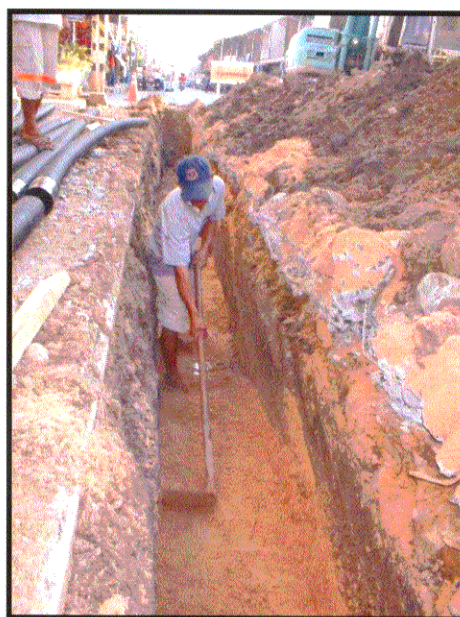
ภาพประกอบการติดตั้งจริง
