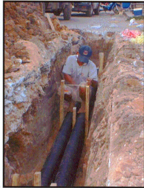
ภาพประกอบการติดตั้งจริง
