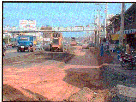
ภาพประกอบการติดตั้งจริง
